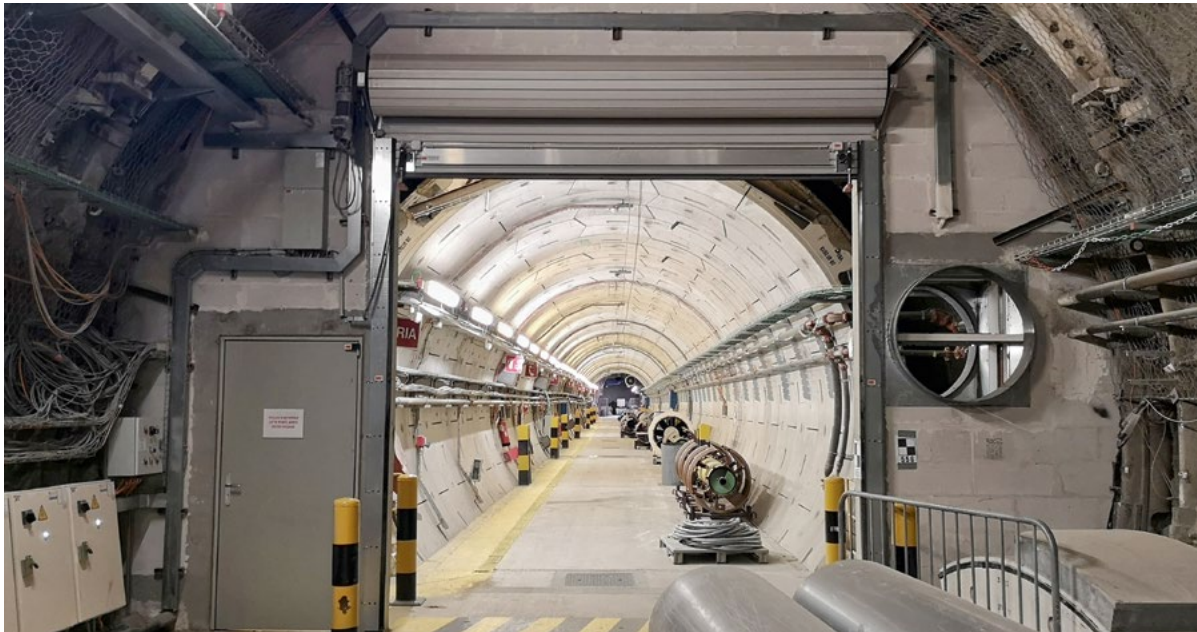
Das Forschungsprojekt TRANSENS zur sicheren Entsorgung radioaktiver Abfälle ist im Oktober 2019 angelaufen.
