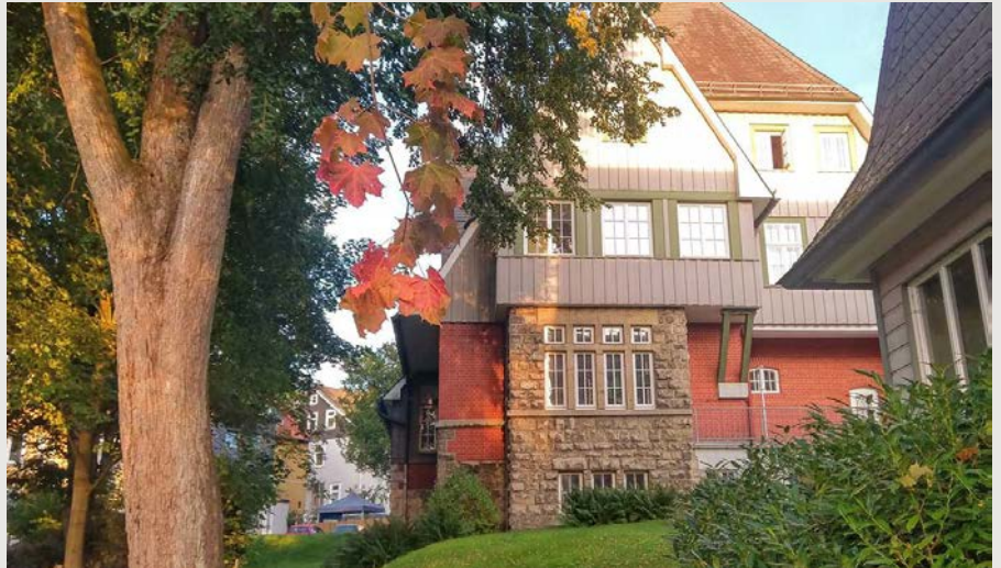
Das Gebäude der früheren Bergschule, der heutigen Fachschule für Wirtschaft und Technik Clausthal-Zellerfeld.
