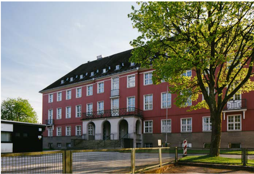
Das Gebäude des Instituts für Anorganische und Analytische Chemie, erbaut in den 1920er-Jahren.
