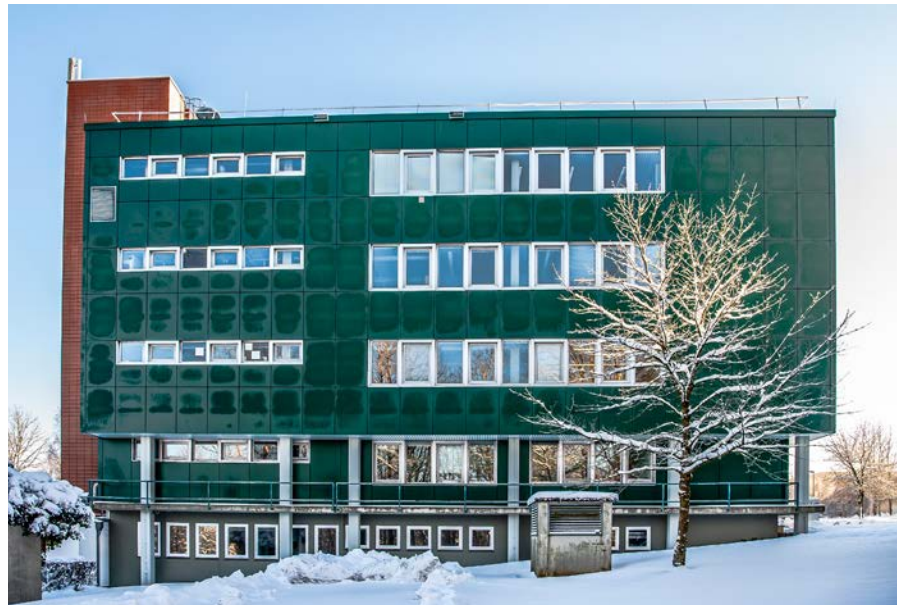
Gebäude des Instituts für Thermische Verfahrens- und Prozesstechnik.
