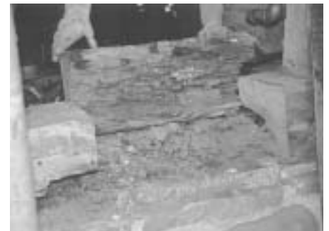
Mehr als 60 % der Eichenschwellen sind verfault.
