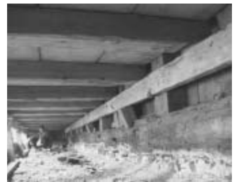
Detailfoto, das stellvertretend für nahezu sämtliche Schwellenbereiche einen Untersuchungsausschnitt der Schwellenkonstruktion des südlichen Langschiffs zeigt. Foto: Verf. Architekt + Sachverständiger AKN Dipl.-Ing. Norbert Möbus Bad Bevensen
